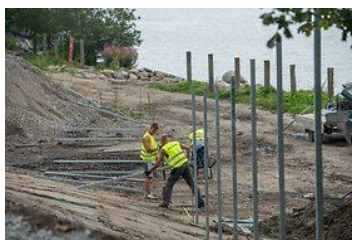
Püstitatav tara sulgeb pääsu Kalaranda. Et ehitust linnaga kooskõlastama ei peaks, paigaldatakse postid madalatesse aukudesse.
